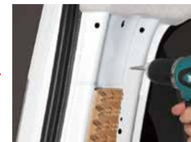
付属のタッピングビスに合わせてドリルで固定穴を開けます。
